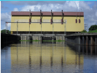
Foto: Het Wakay pompgemaal
